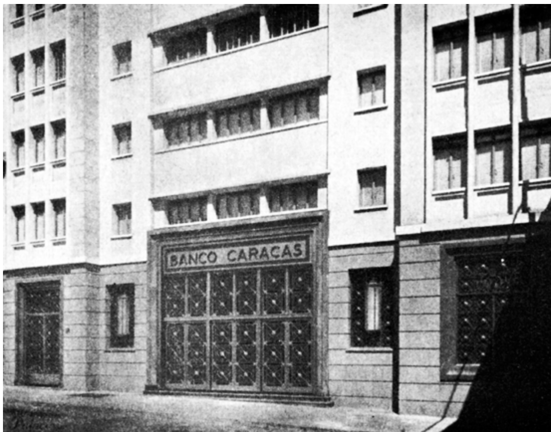
Banco Caracas, acceso principal, 1951.
