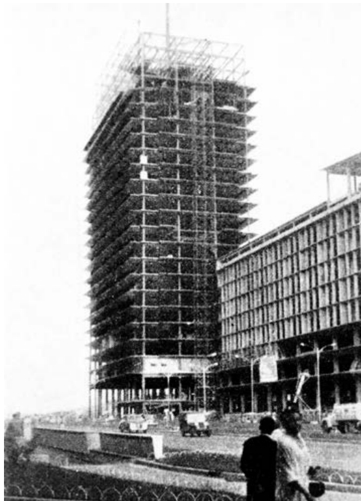
Torre Sur, Bloque Norte de la Av. Bolívar.
